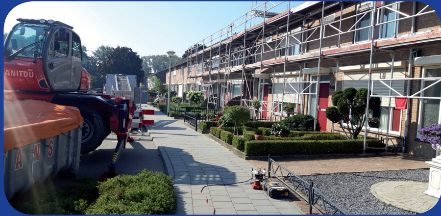
Dak renovatie in de sintenwijk in Liessel
